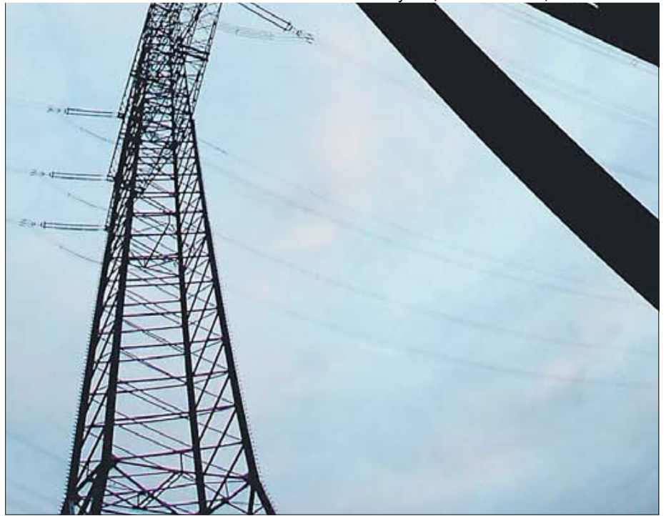
Jahrzehntlang wurden Hochspannungsmasten mit Bleimennige gestrichen, um sie vor Rost zu schützen.
